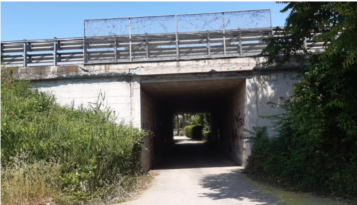
Sottopasso di via Salinello
