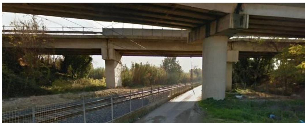
Fig. 9 – Sotto-attraversamento CVF rampa di raccordo dell'Autostrada A25
