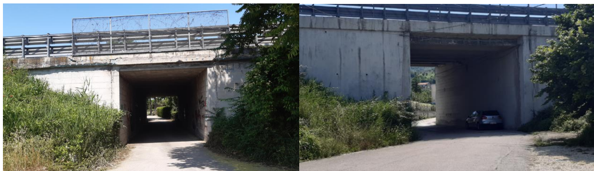
Sottopassi di via Salinello e di via Vibrata
