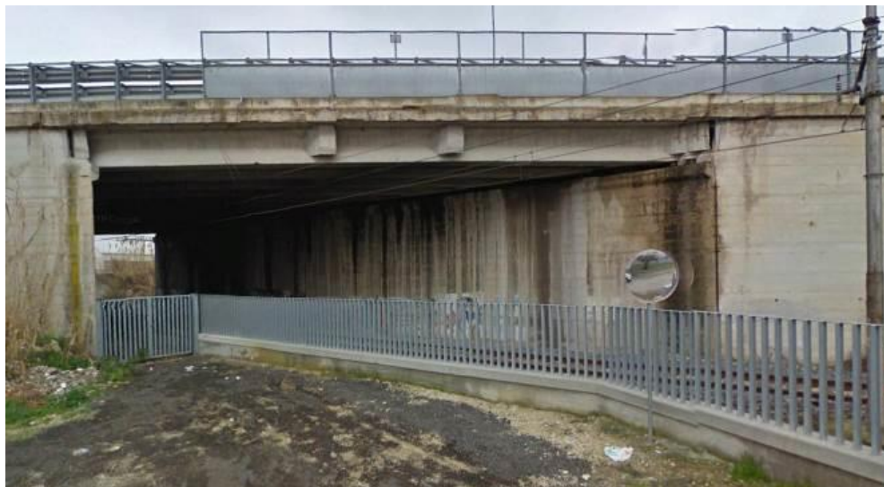
Fig. 5 – Sotto-attraversamento esistente Asse Attrezzato PE-CH
