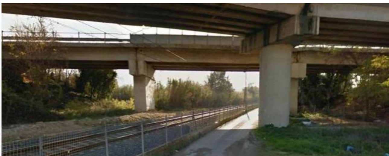
Fig. 11 – Sotto-attraaversamento CVF rampa di raccordo dell'Autostrada A25
