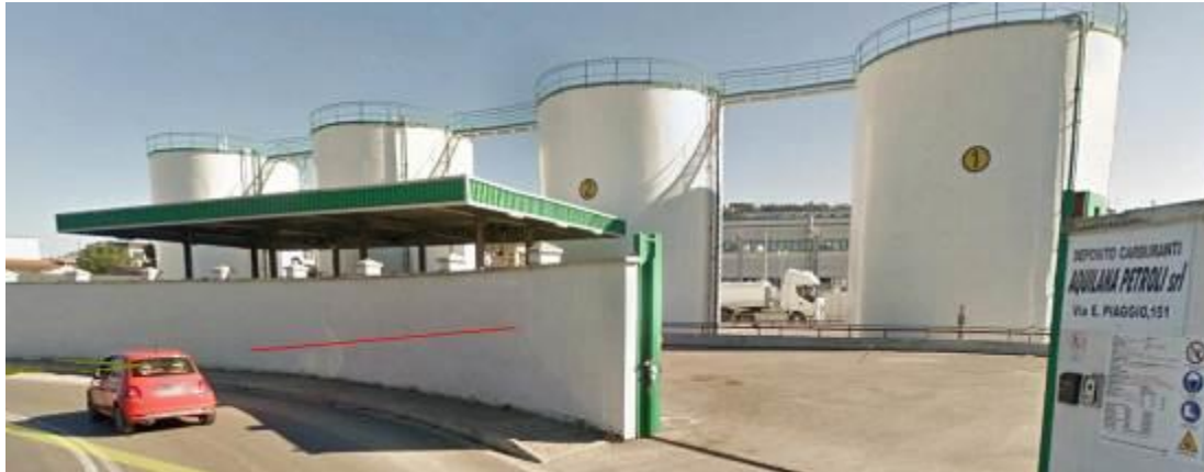
Fig. 3 – Deposito carburante esistente al km 13+400 circa
