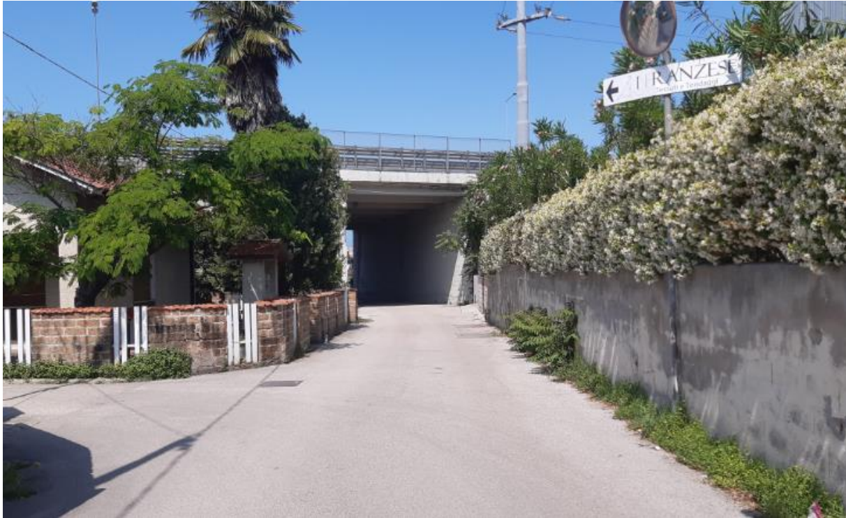
Vista del sottopasso di via Vibrata.
