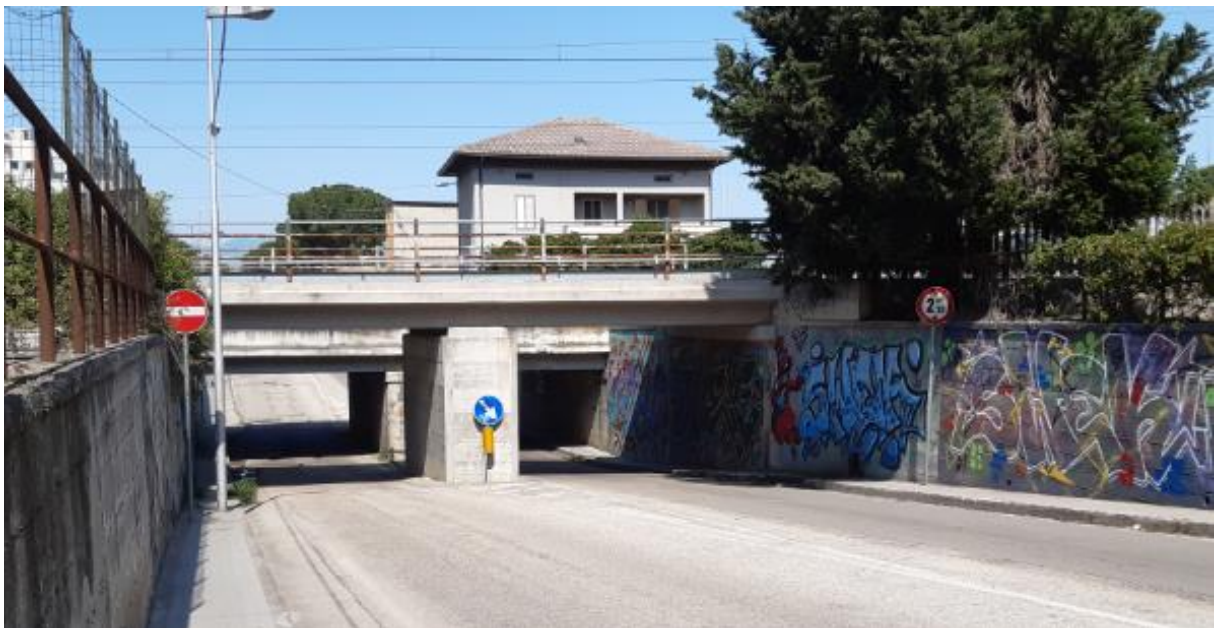
Vista dei sottopassi da via ss5
