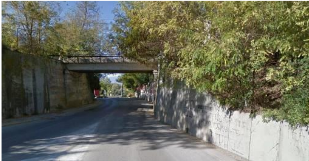
Fig. 7 – Ponte attuale su Via Tirino
