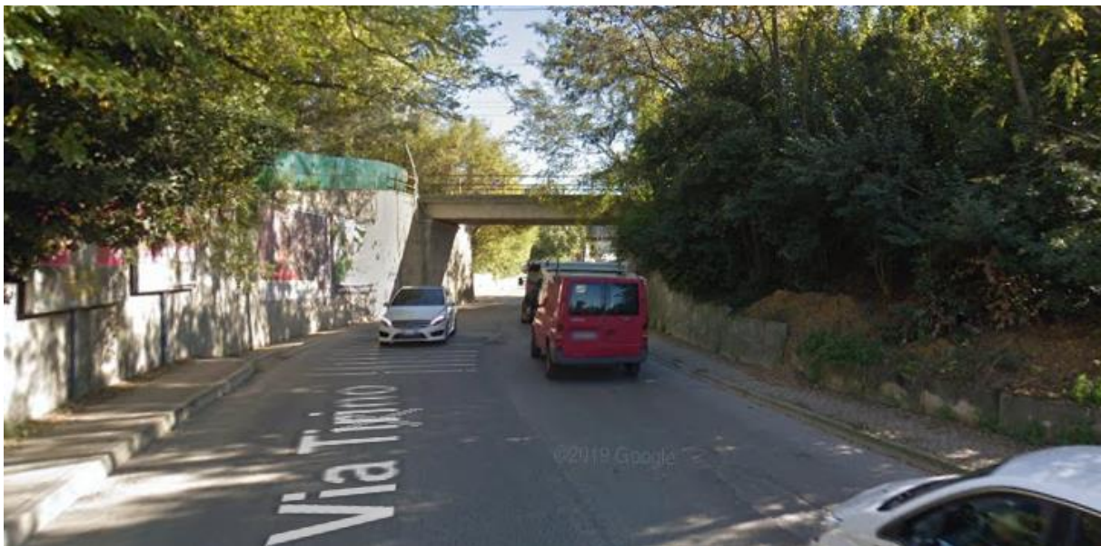
Vista dell'attuale viadotto ferroviario da via Tirino
