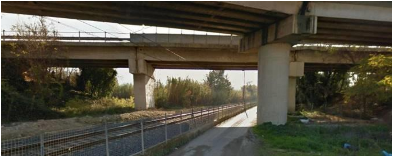
Fig. 11 – Sotto-attraversamento CVF rampa di raccordo dell'Autostrada A25
