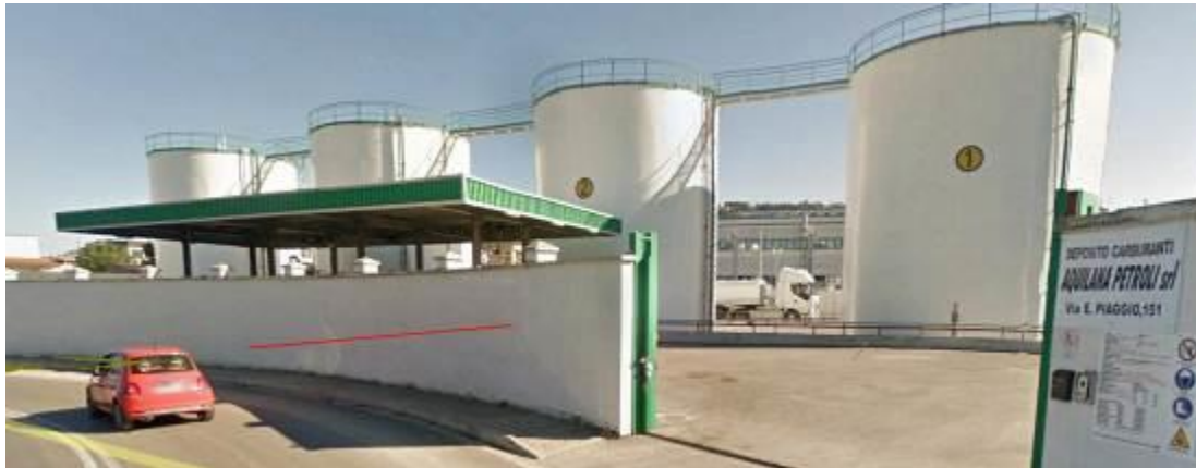
Fig. 5 – Deposito carburante esistente al km 13+400 circa
