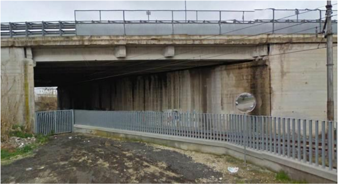
Fig. 7 – Sotto-ataversamento esistente Asse Attrezzato PE-CH
