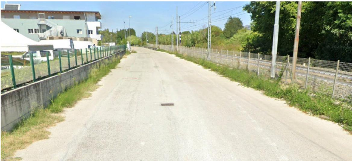
Per quanto concerne la segnaletica orizzontale lungo il tratto stradale oggetto di intervento si rileva uno stato di degrado della stessa, con caratteristiche di luminosità e riflettenza che non rispondono ai requisiti prestazionali minimi tali da garantire un adeguato livello di sicurezza dell'infrastruttura.
