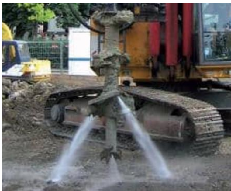
Figura 2: Particolare pulizia ugelli in wet deep mixing
