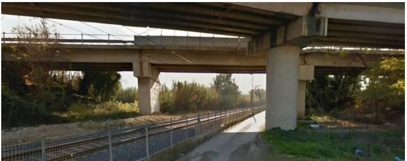
Fig. 10 – Sotto-attraversamento CVF rampa di raccordo dell'Autostrada A25
