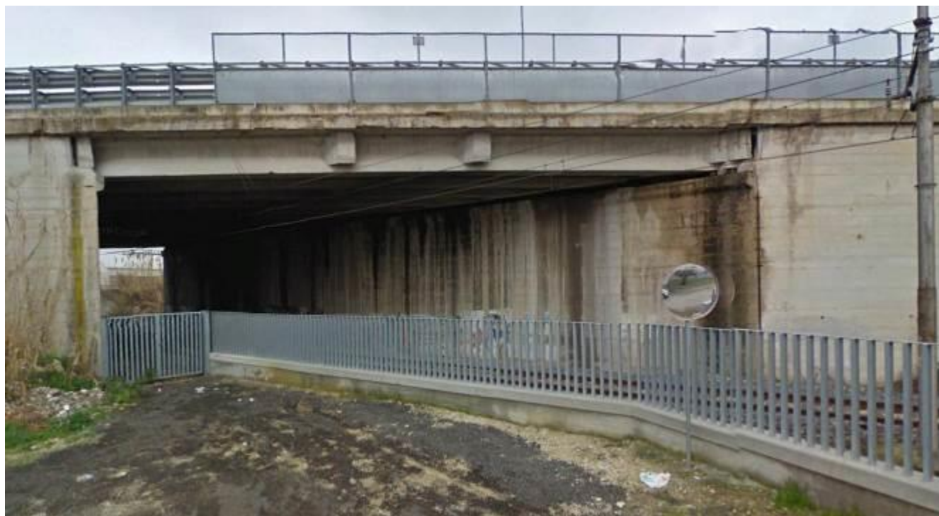
Fig. 6 – Sotto-attraversamento esistente Asse Attrezzato PE-CH
