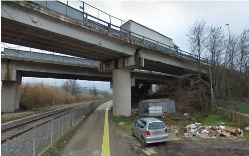
Fig. 48 – Viabilità stradale alternativa a Via Vella - vista del cavalcaferrovia autostradale esistente
