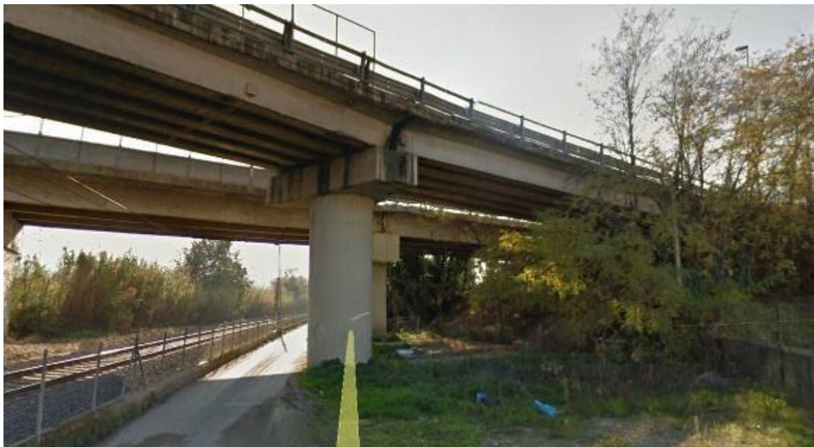
Fig. 49 – Viabilità stradale alternativa a Via Vella - vista del ponte esistente in corrispondenza del quale vi sarà l'attraversamento del tracciato della nuova viabilità
