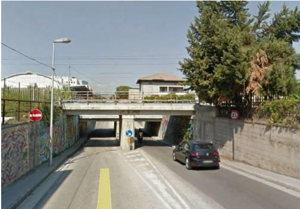
Fig. 39 – Viabilità stradale di Via Enrico Mattei al km 12+950,000 (NV31) - vista sottovia esistente (dir. E. Piaggio)
