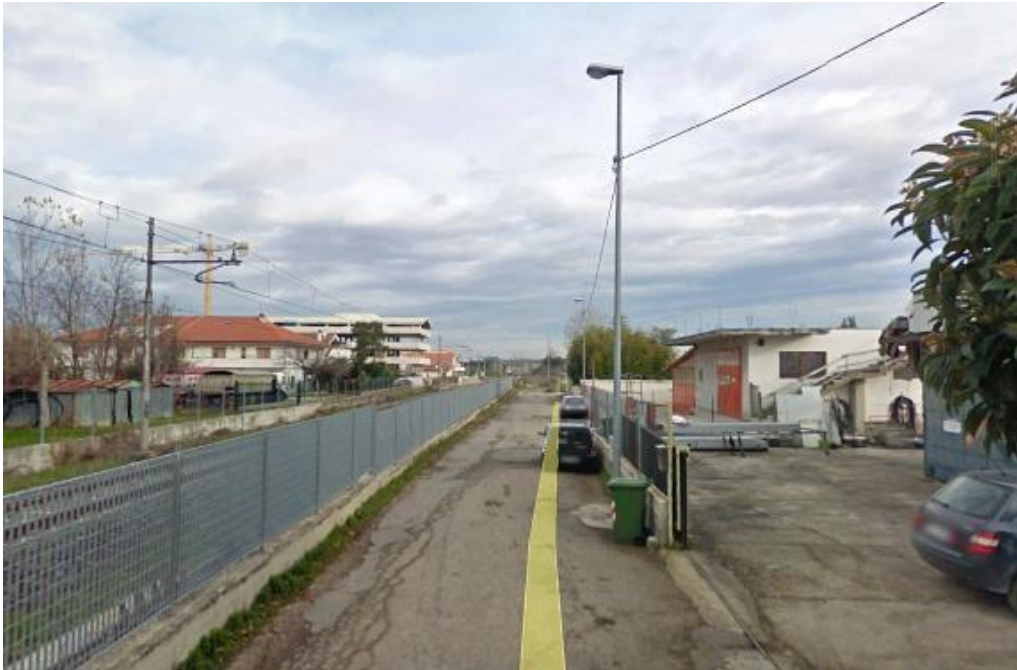
Fig. 44 – Viabilità stradale Via Vibrata, tratto interrotto dalla nuova sede ferroviaria
