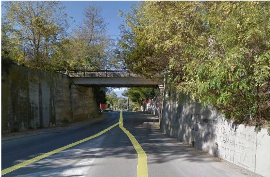
Fig. 46 – Viabilità stradale Via Tirino, sottovia al km 14+250.00 (NV34) Vista sottovia esistente lato est
