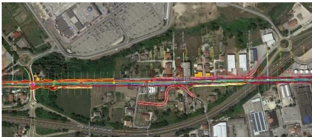
Fig. 7 – Tratto tra il km 13+710 ed il km 14+240
