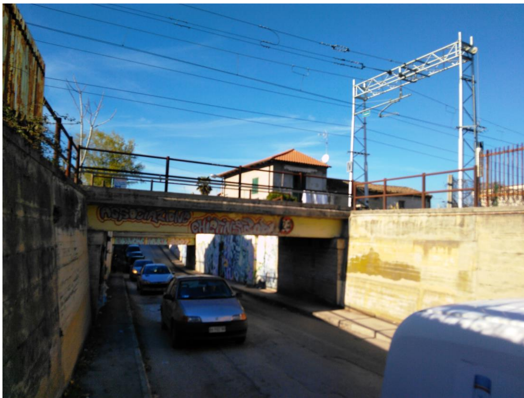
Figura 1 Stato di fatto
