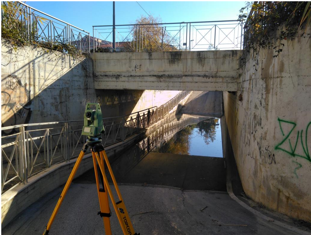
Figura 1 Stato di fatto
