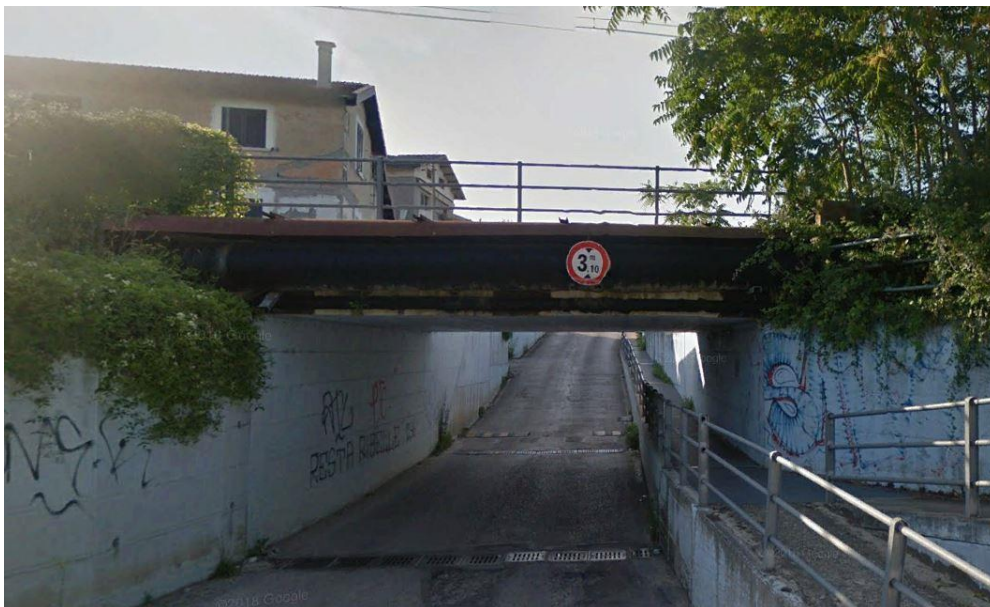
Figura 1: Stato di fatto
