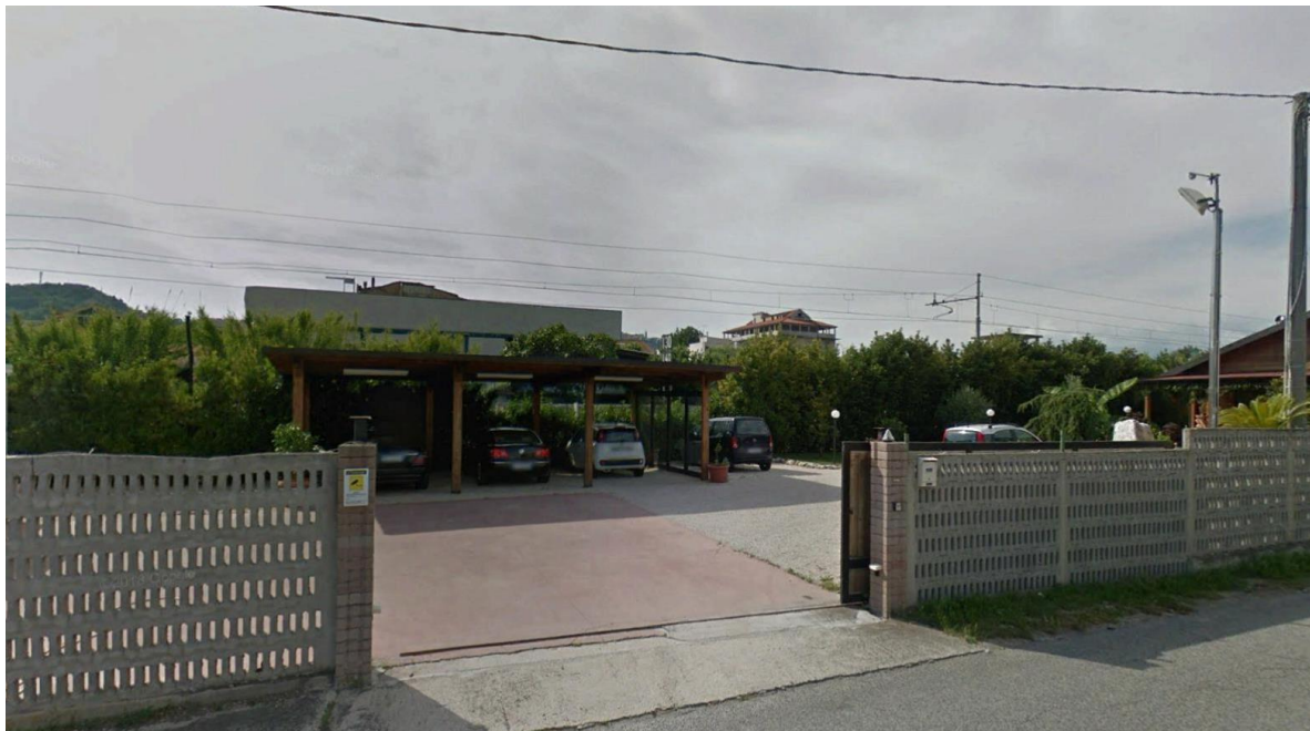
Fig. 35 - Vista frontale Fabbricato 50 (pensilina per parcheggio)
