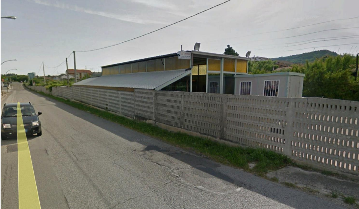
Fig. 34 - Vista frontale Fabbricato 50
