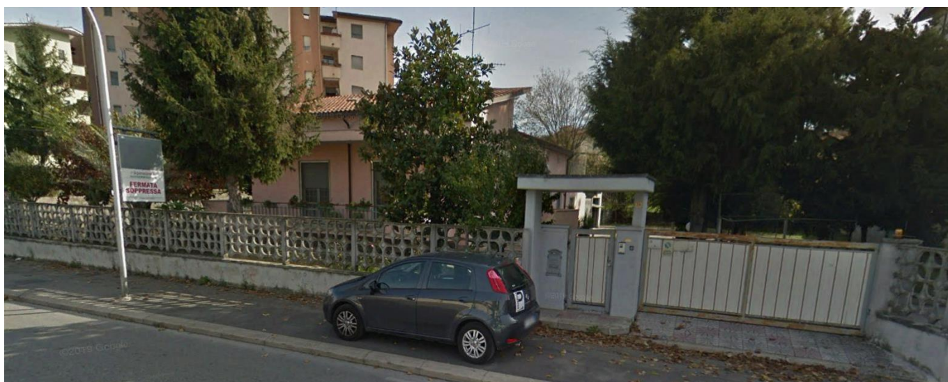
Fig. 73 - Vista Fabbricato residenziale 75
