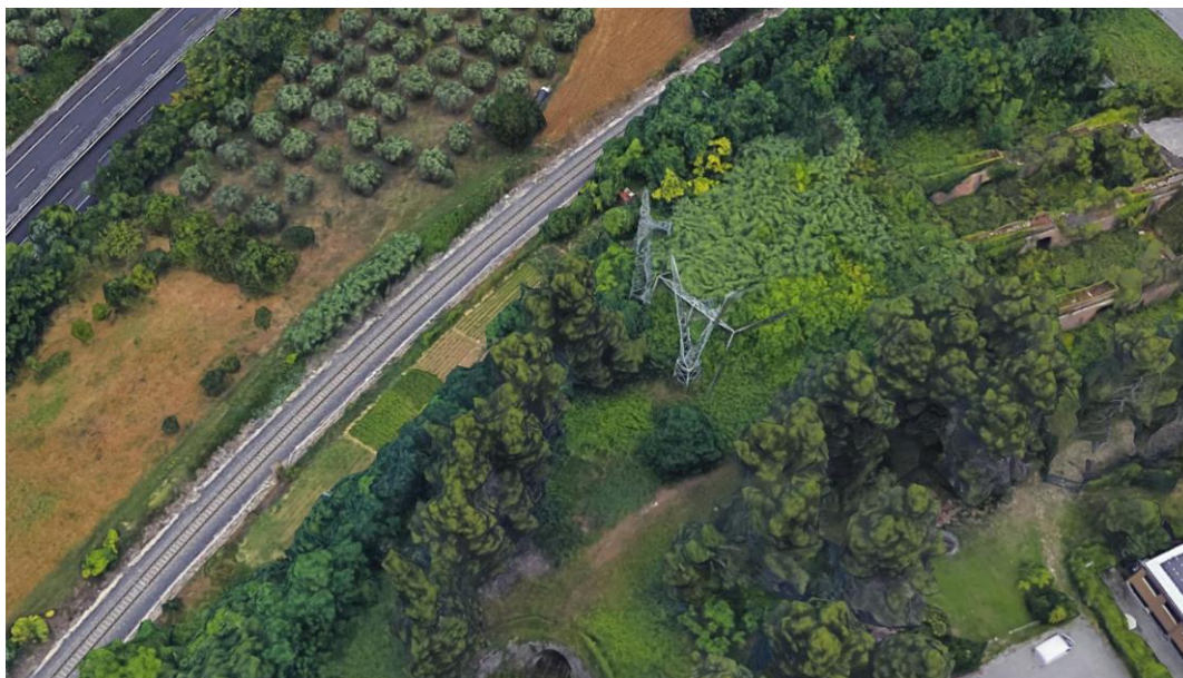
Fig. 11 - Vista Fabbricato 40 (tralicci alta tensione)
