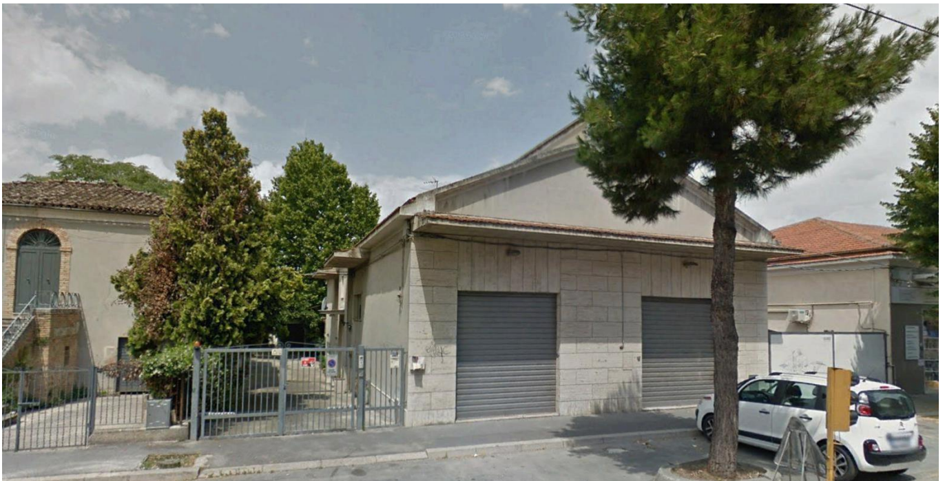
Fig. 51 - Ingresso ai Fabbricati 56
