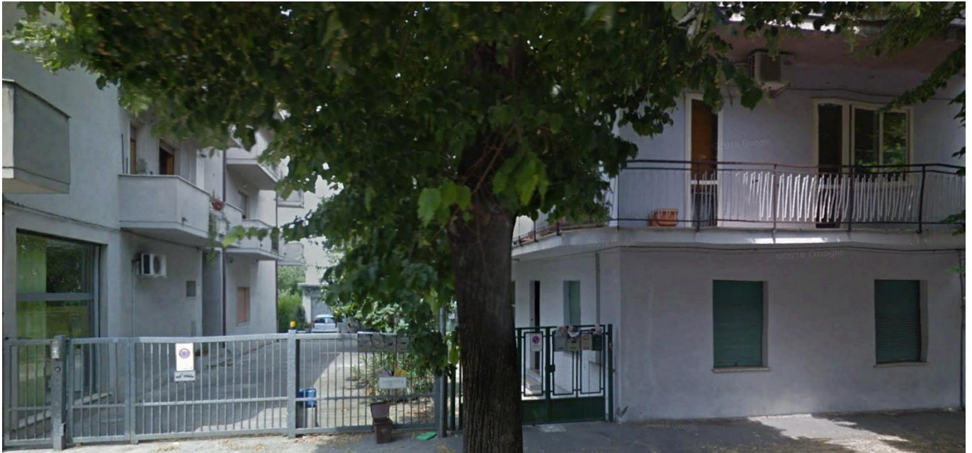
Fig. 56 – Ingresso ai Fabbricati 60
