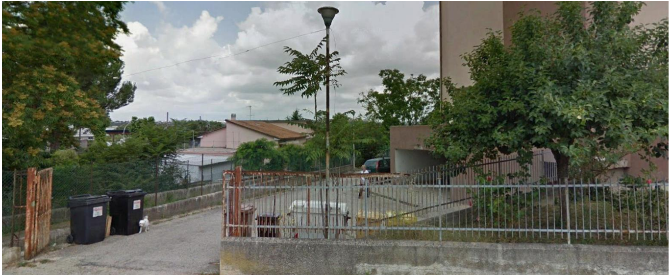
Fig. 74 - Vista Fabbricato residenziale 75
