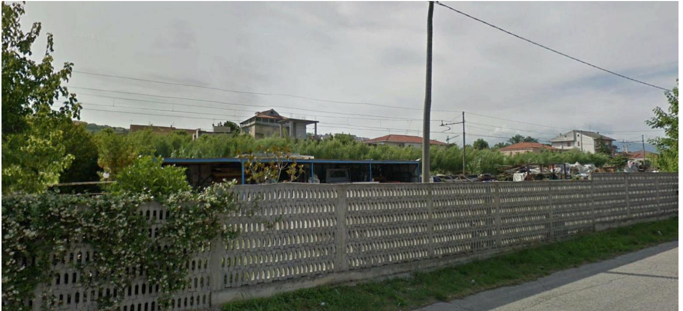
Fig. 40 - Vista prospetto Fabbricato 52
