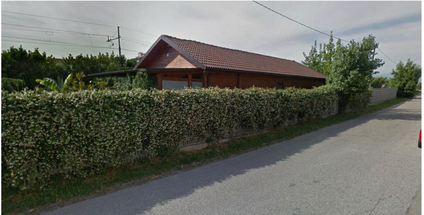
Fig. 38 - Vista frontale Fabbricato 51
