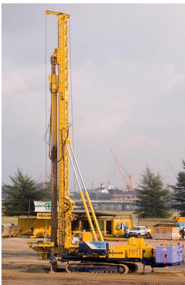
Figura 4: Tipica attrezzatura per colonne di ghiaia con immissione della ghiaia a secco a fondo foro
