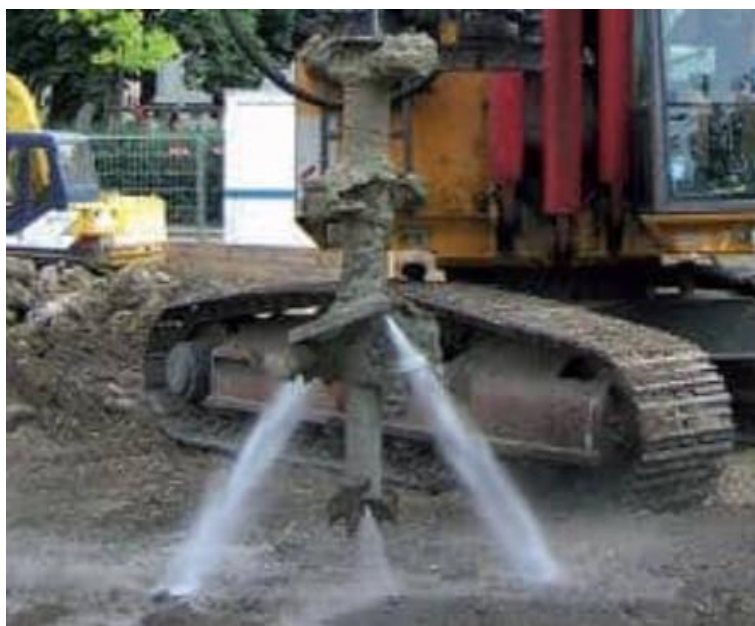
Figura 2: Particolare pulizia ugelli in wet deep mixing
