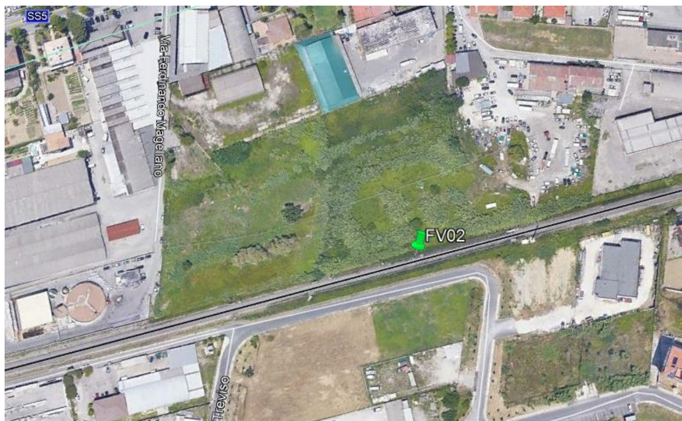
Vista aerea dell'area AT.08 e individuazione posizione FV02.
