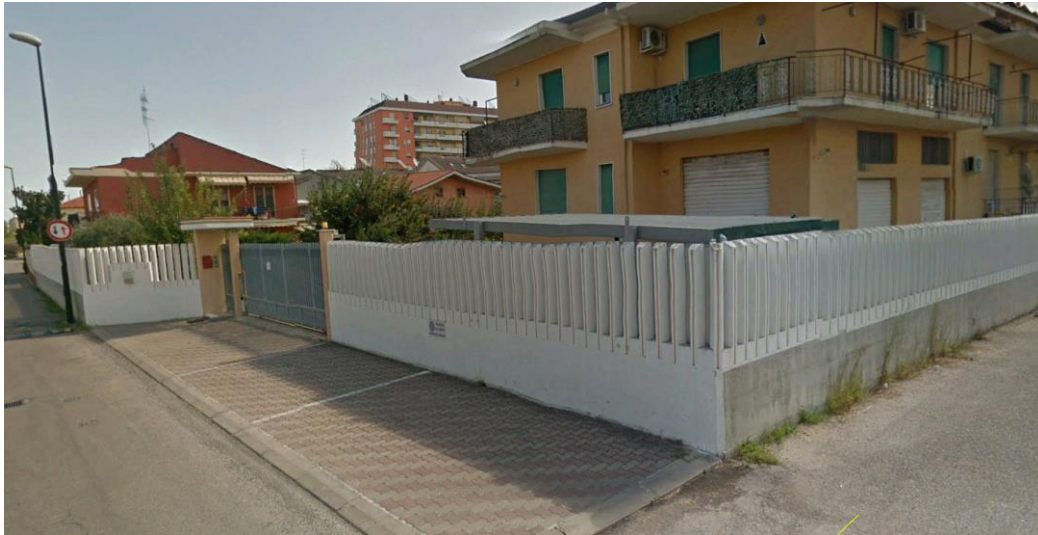
Muro di recinzione fabbricato
