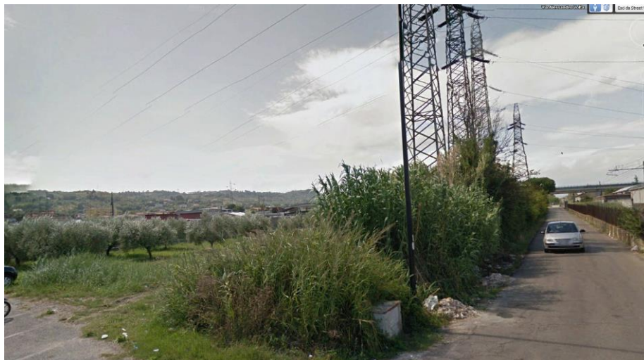
Tralicci alta tensione tra il km 1+600 ed il km 1+750
