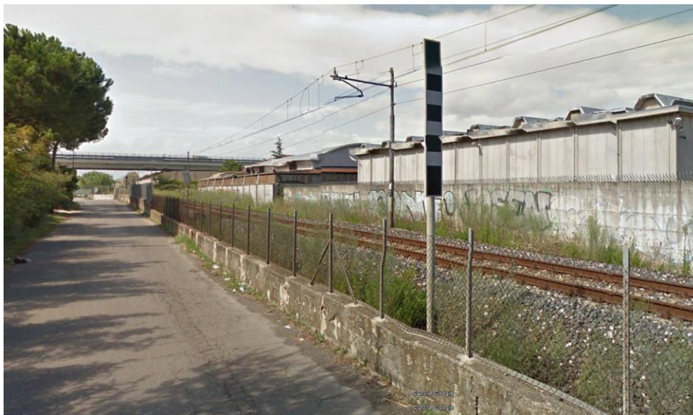
Capannoni industriali al km 1+780 circa
