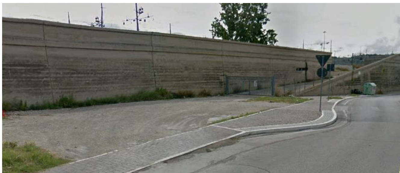
Vista rampa di accesso alla AR.01 da rotatoria di via Alento.
