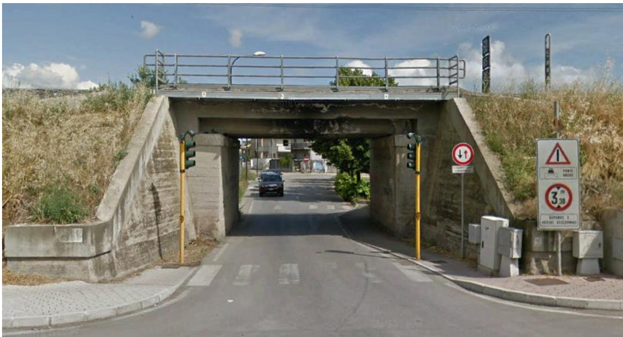
Figura 1: Stato di fatto
