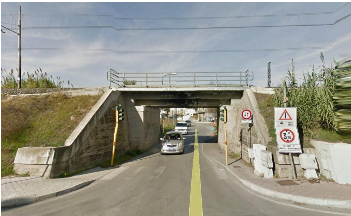
Figura 10 - Stato di fatto, Vista di Via Volta (NV01A)
