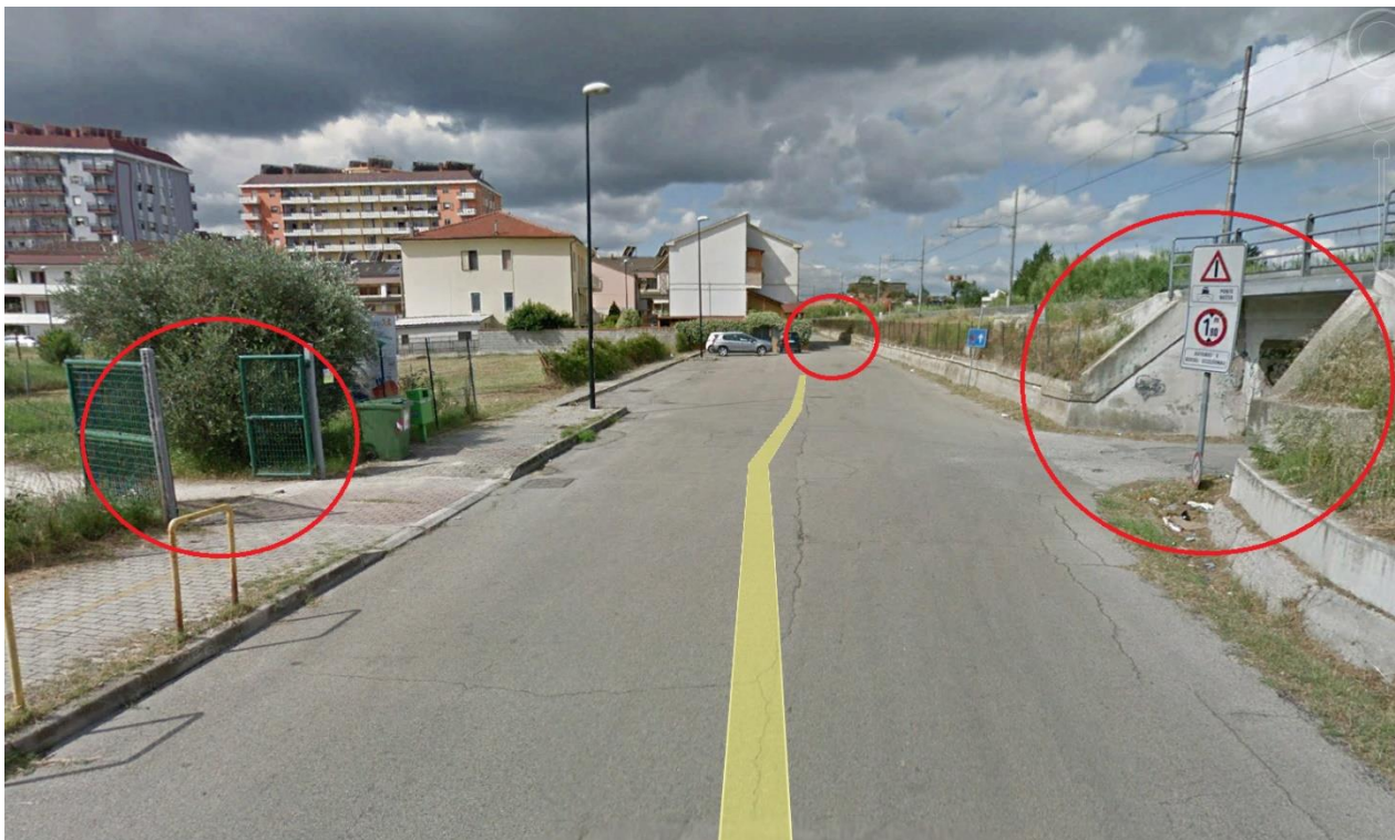
Figure 15 - Stato di fatto, Panoramica di Via Po (NV02B) in direzione di Chieti
