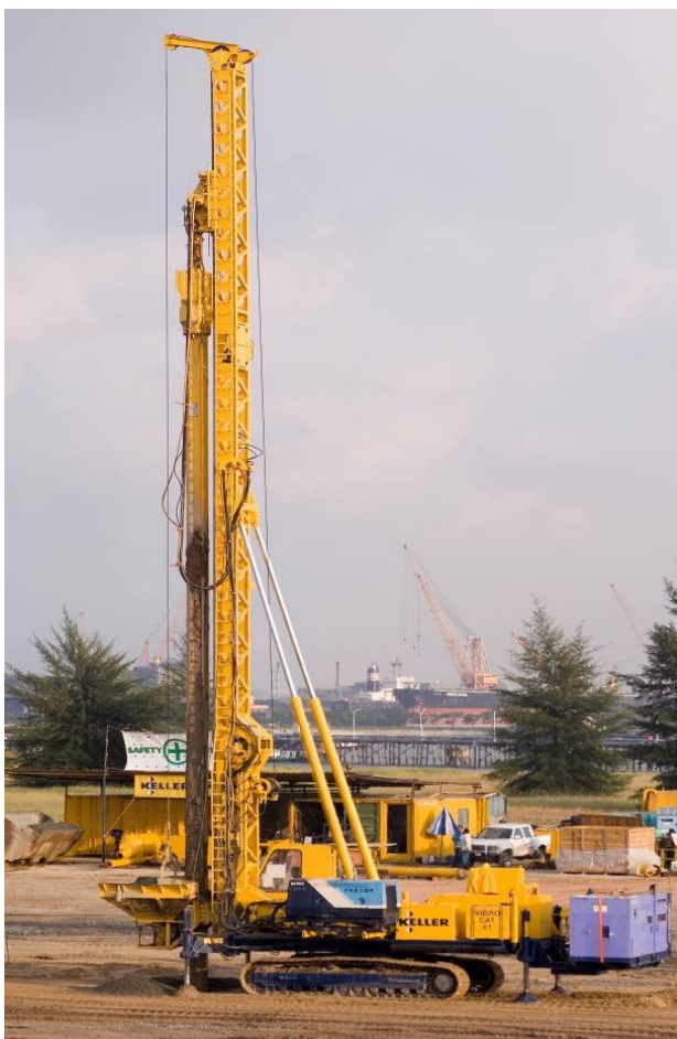
Figura 5: Tipica attrezzatura per colonne di ghiaia con immissione della ghiaia a secco a fondo foro
