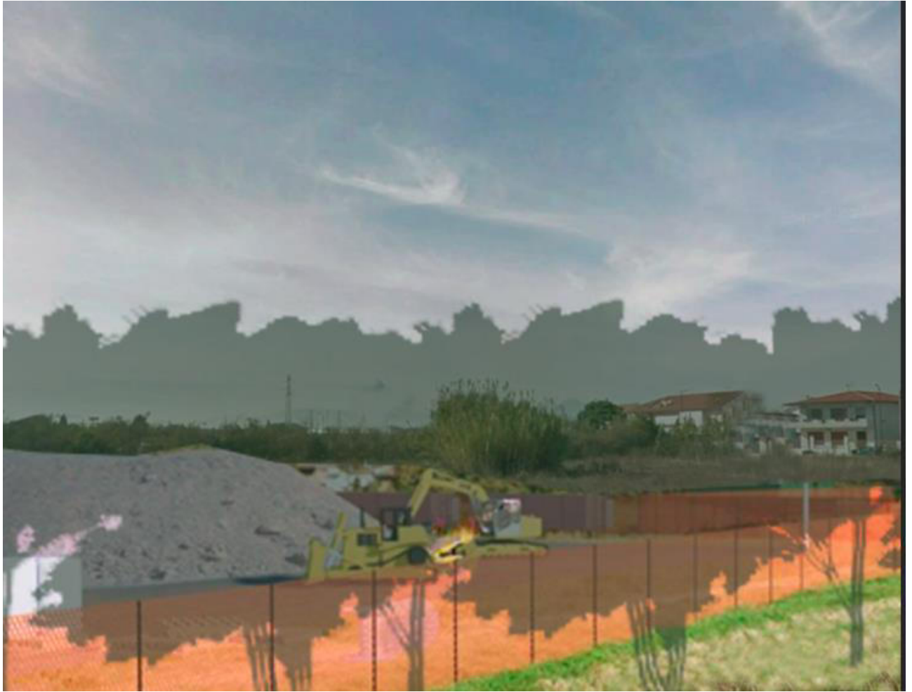
Cantieri in prossimità Cavalca ferrovia di via Tiburtina SS5” – IV01:
